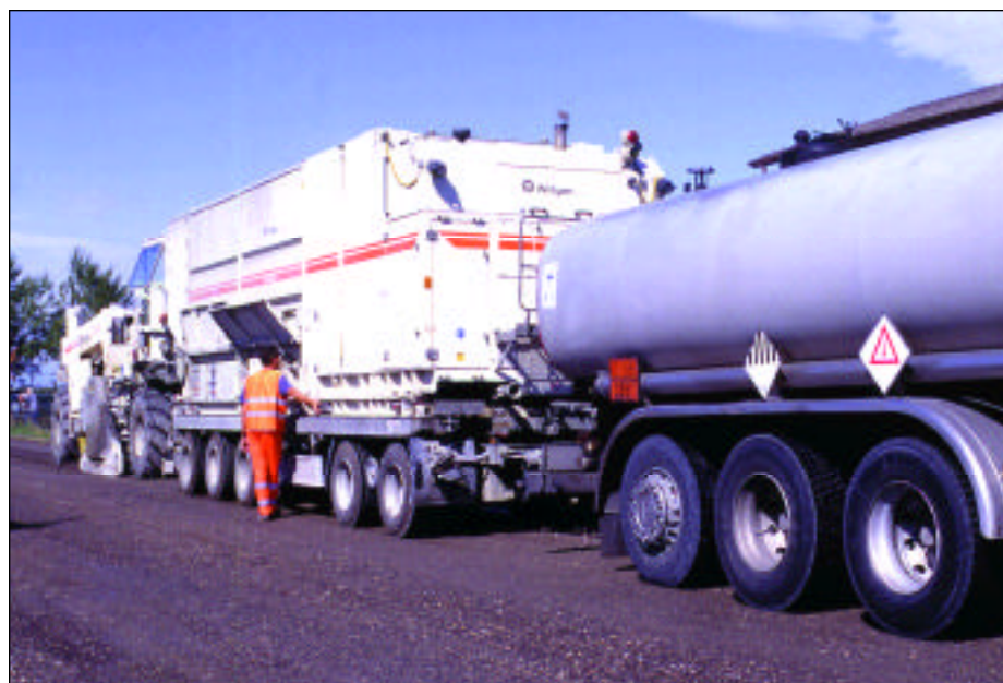
Il rifacimento del conglomerato ammalorato con la tecnica del bitume schiumato e' realizzato in tempi molto rapidi e permette la pressoche' immediata riapertura della strada al traffico.
